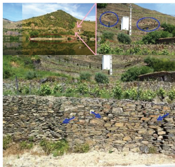
Fig. 2. Aspecto parcial do cais de Sabrosa, escorregamentos na encosta a montante e localização da rotura no muro de gabiões.
