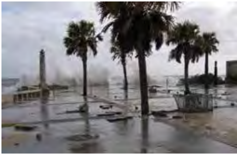
Fig. 3. Galgamento oceânico e destroços no passeio em Paço de Arcos no dia 01/03/2018.
