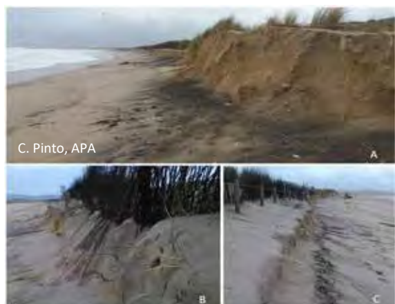
Fig. 9. SJC em 04/03/2018 (fotografia A) e em 06/03/2018 (fotografias B, C) – zona centro-sul. Escarpamento da base da duna desde o apoio de praia/restaurante Pé nú (A) e o Kontiki (B); escarpa afetando a berma entre o Kontiki e o Sunset (C).
