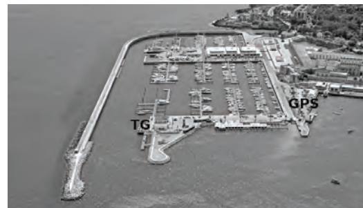
Fig. 1. Marégrafo de Cascais (TG) e estação GPS.
