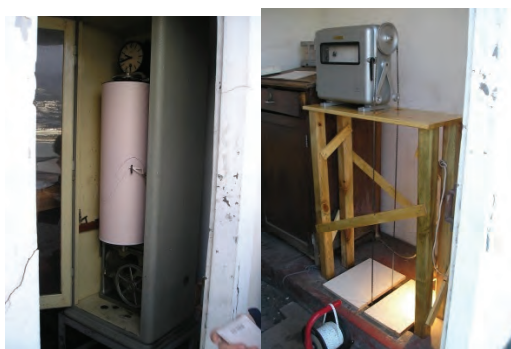
Fig. 2- Mareógrafo AOTT Bozum de tambor vertical (1976) e mareógrafo AOTT R20 (2007) instalados no Funchal.
