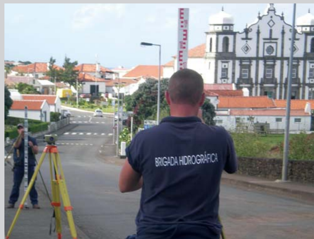
Execução de nivelamento geométrico na Ilha das Flores
