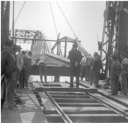
Desmontagem da ponte sobre o rio Coina.
