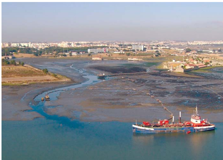
Draga de sucção a operar no canal de acesso às INAZ com apoio de batelão Mareta.
