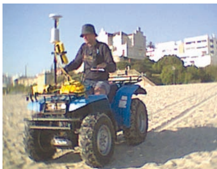
Execução de topografia de uma praia com moto 4
