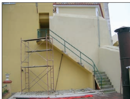
Obras da escada de acesso ao parque de viaturas
