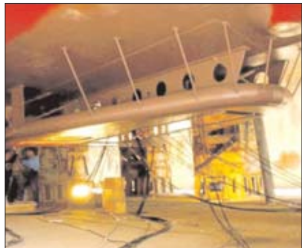
Montagem da gôndola no NRP «D. Carlos I»
