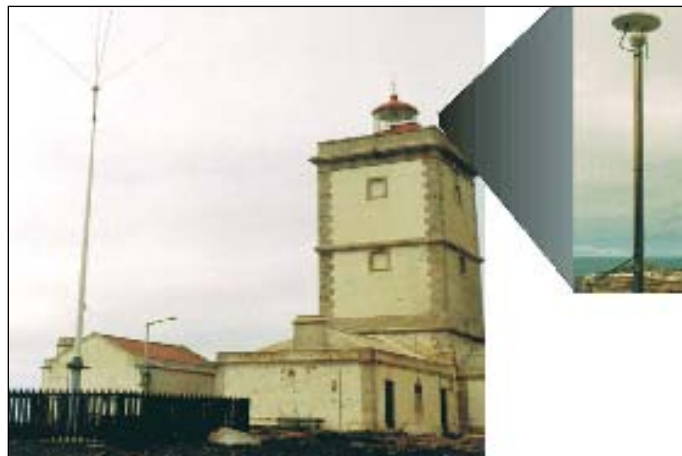
Fig. 2 – Imagem das antenas da estação DGPS experimental instalada no Cabo Carvoeiro. Em primeiro plano está a antena transmissora, vendo-se também a antena GPS, montada junto à cúpula do farol e da qual se mostra um grande plano (à direita).
