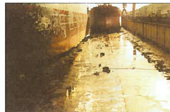
Vista do interior da Doca seca n.º 13 dos Estaleiros da Lisnave
