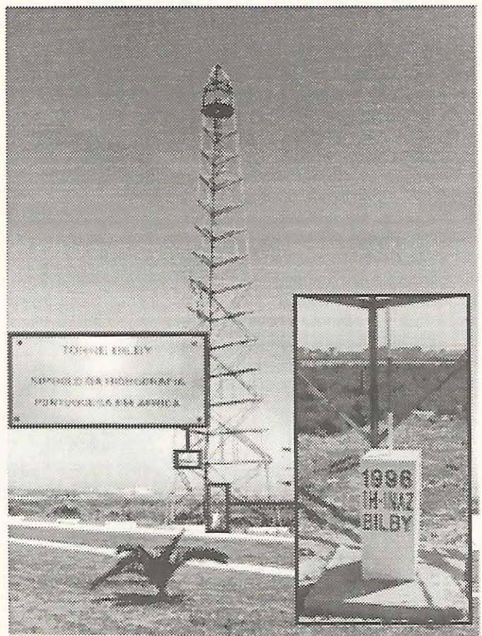
- Torre Bilby - Instalações Navais da Azinheira
